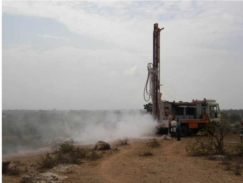
Figure 3 . Forage en cours de réalisation dans un aquifère granitique, au moyen de la méthode du « marteau fond de trou ». Kothur, Andhra Pradesh, Inde. [© B. Dewandel]
