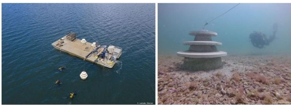
Figure 13. Restaurer les anciennes huîtres du passé : implantation de récifs en béton coquillés afin de favoriser le recrutement et redynamiser les populations d'huîtres plates du banc du Roz, en rade de Brest et du banc de Penthièvre en baie de Quiberon. [Source : © IFREMER / Stéphane Lesbats (à gauche) & / Stéphane Pouvreau (à droite)]
