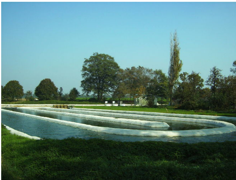
Figure 8. Bassin ouvert utilisé pour la culture de microalgues. L'eau est constamment maintenue en mouvement grâce une roue à palettes motorisée. [Source : By JanB46 [CC BY-SA 3.0], via Wikimedia Commons]
