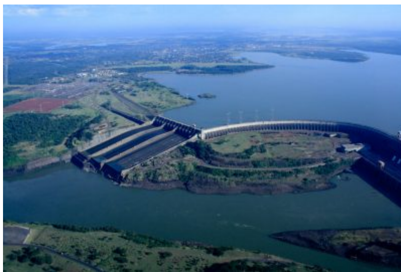
Figure 3. Centrale hydroélectrique d'Itaipu, sur le Rio Paraná, à la frontière entre Brésil et Paraguay. [Photo © International Hydropower (CC BY 2.0)]
