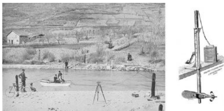
Figure 5. Jaugeage par exploration du champ des vitesses sur la Durance à Embrun (Hautes Alpes) en 1910 ; à droite, moulinet principe Woltman de marque "Richard" mis en œuvre depuis la barque.
