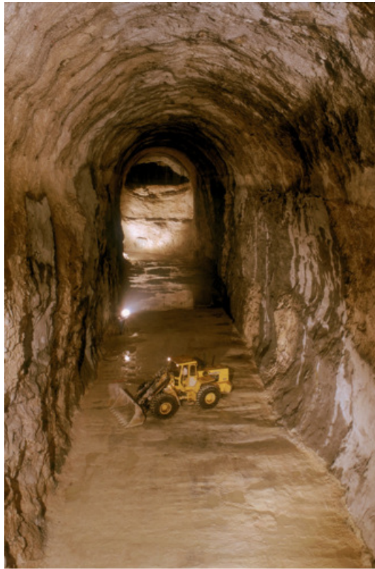
Figure 3. Creusement d'une galerie de stockage non revêtue à Lavéra [Source : © Phototèque Géostock]
