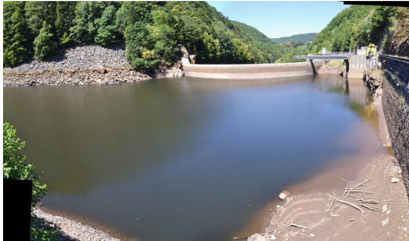
Figure 6. Barrage de Vaussaire en période d'étiage. Le marnage peut également être dans certaines conditions de plusieurs mètres. Cette exposition aux conditions atmosphériques peut favoriser certaines réactions (oxydation notamment) au sein de la matrice sédimentaire [Source : © A. Courtin-Nomade].
