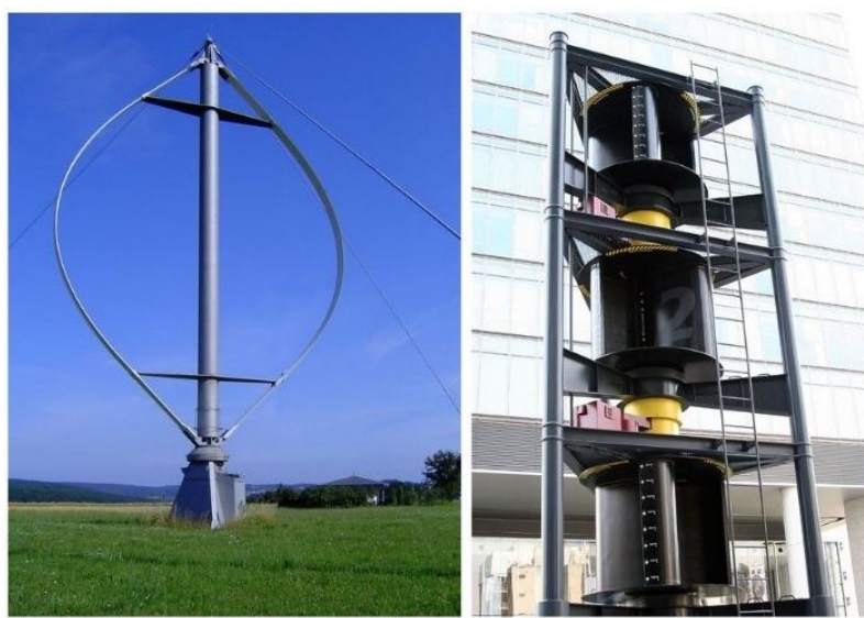
Figure 4. Exemples d'éoliennes à axe vertical. A gauche, éolienne du type Darrieus et à droite, éolienne du type Savonius [Source : A gauche : W. Wacker, Public domain, via Wikimedia Commons - à droite : Toshihiro Oimatsu, CC BY 2.0 , via Wikimedia Commons]
