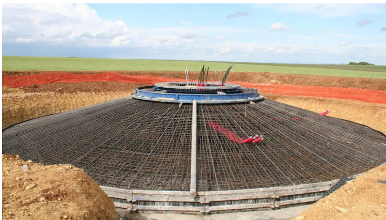
Figure 10. Fondation gravitaire pour éolienne multi-MW en cours de réalisation [Source : © Enerfip - Fondations des éoliennes : revoir les bases - droits réservés]
