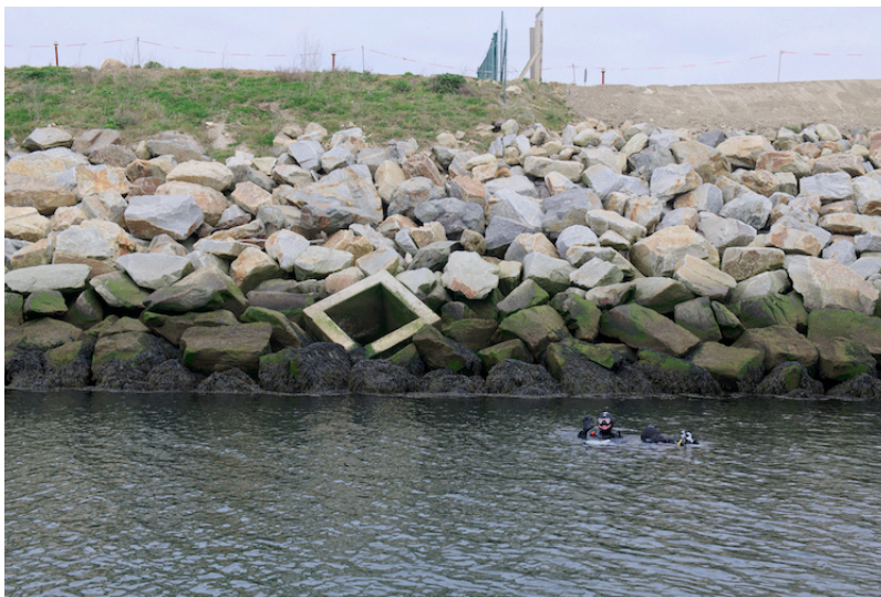
Figure 4. Exemple d'éco-bloc mis en place dans la digue du port de Brest (Bretagne-France). Ces éco-blocs restent remplis d'eau à marée basse, recréant artificiellement des flaques caractéristiques des côtes rocheuses des mers à marées. [Source © Ifremer – O. Dugornay].
