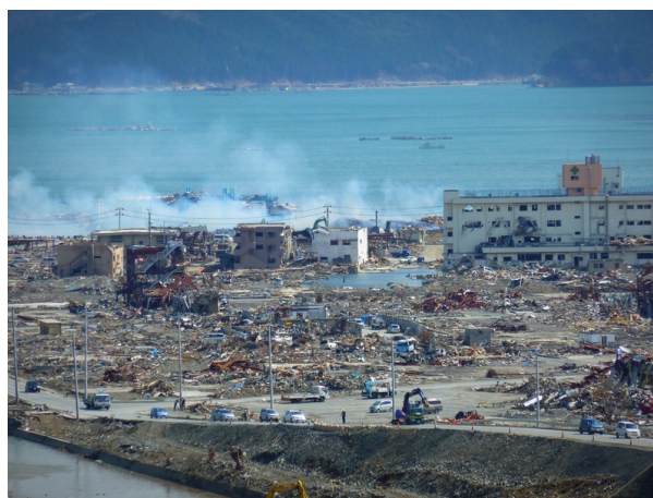
Figure 2. Dégâts du tsunami de 2011 au Japon (© kariochi, Fotolia#95003063)
