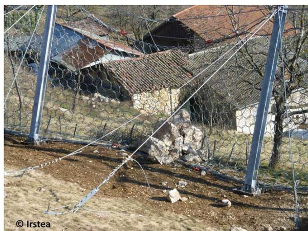
*Figure 9. Filets déformables, Ripaillère [Source : IRSTEA]*
